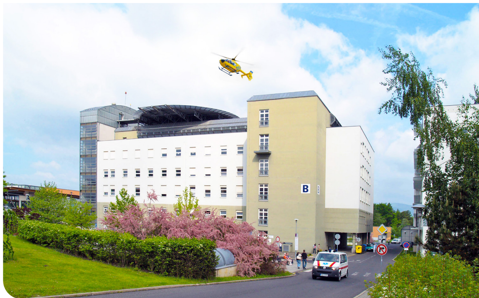
Budova B s heliportem v areálu Krajské zdravotní, a.s. – Masarykovy nemocnice v Ústí nad Labem, o.z.
