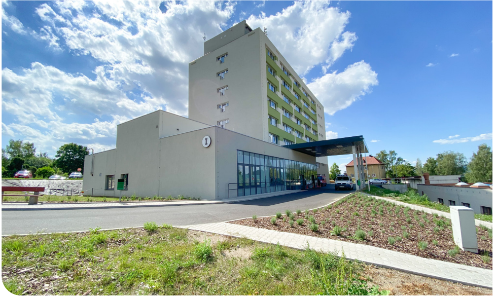
Павільйон терапевтичних спеціальностей на території компанії АТ «Крайська zdravotní» – Лікарні м. Дечин
